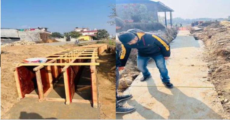
गुरुङटोला देखि नगरपालिका आउने सडक नाली सहित कालोपत्रे निर्माण हुदै ।
