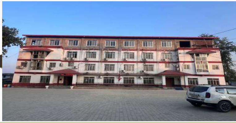
नगर कार्यपालिकाको कार्यालयमा निर्माणाधिन सभाहल
