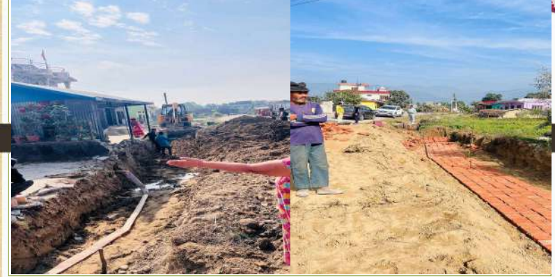
गुरुङटोला देखि नगरपालिका आउने सडक नाली सहित कालोपत्रे निर्माण हुदै ।
