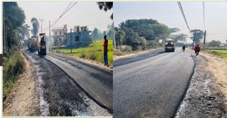
वडा नं. ८ को सिमाना देखि लिलाधार पराजुलीको घर सम्म बाटो निर्माण हुदै गर्दा ।
