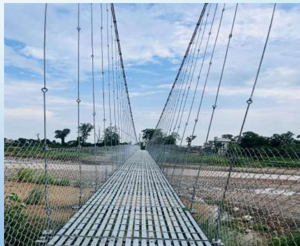
निर्माण पश्चात झोलुङ्गे पुल
